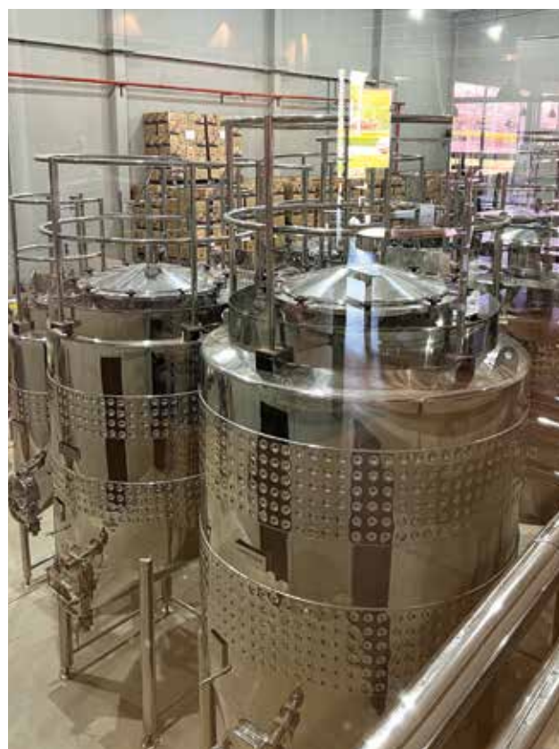
Tanques de fermentação com controle de temperatura
